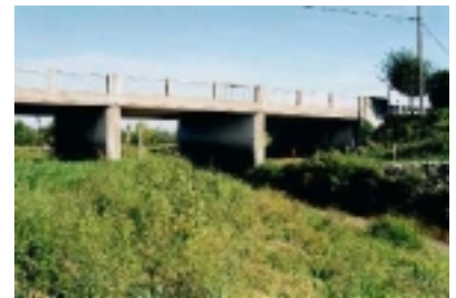
Reprise de la végétation seulement 3 mois après
