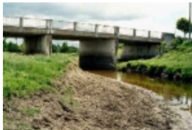
Berge avant installation de clôtures
