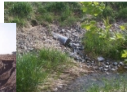
Stabilisation de sortie de drain
