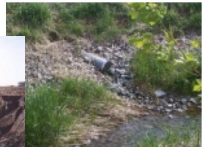
Stabilisation de sortie de drain
